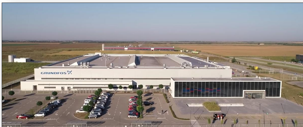
Слика 8. Постројење фабрике „Grundfos” у Инђији (извор: Grundfos, 2025)
