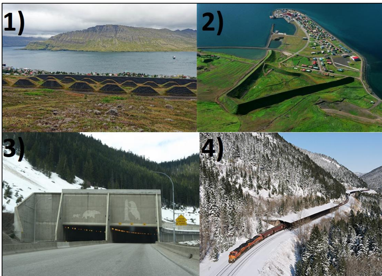
Слика 79. Бране за заштиту од лавина (1,2) на Исланду и снежне шупе (3,4) у Канади и САД
