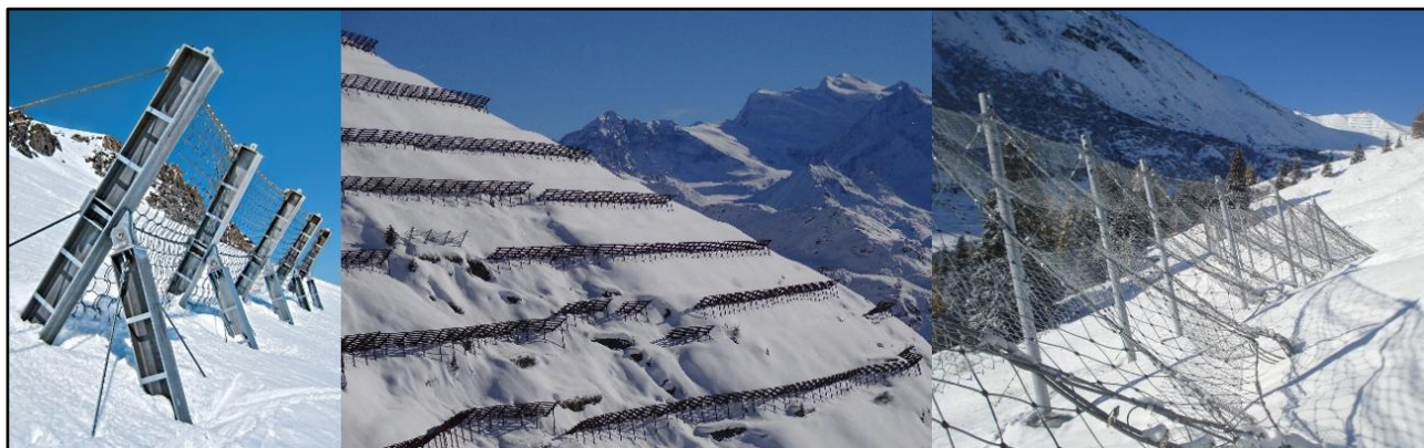
Слика 78. Потпорне конструкције за спречавање активирања лавина
