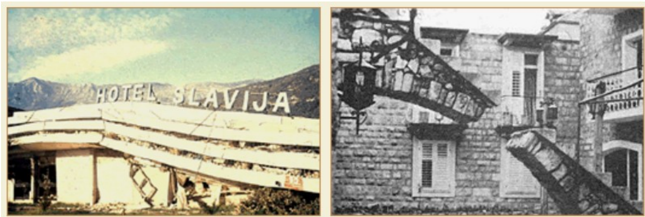
Слика 14 и слика 15. Срушени хотел „Славија“ и улаз у стари град у Будви. Извор: ЗХМСЦГ.
