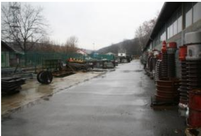
Слика 6.16: Складиштење отпада у складишту бр. 045 у Топчидеру
