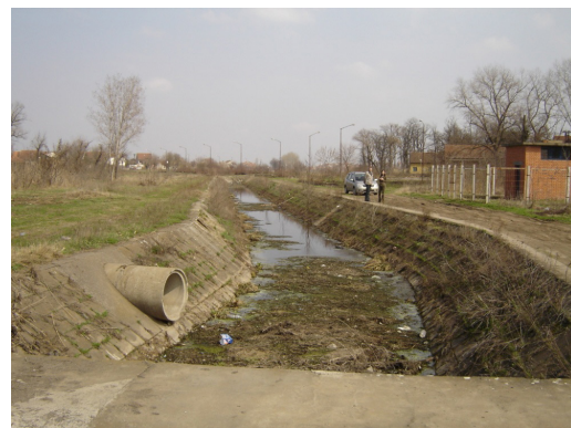
Slika 2. Kanal za otpadne vode pored lokacije izvorišta "Šumice"
